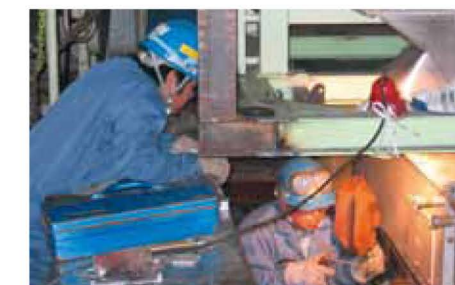
限られた狭いスペースでの作業も
