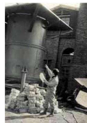
初期の頃の製缶作業。得意先でのメンテナンス作業も多かった
