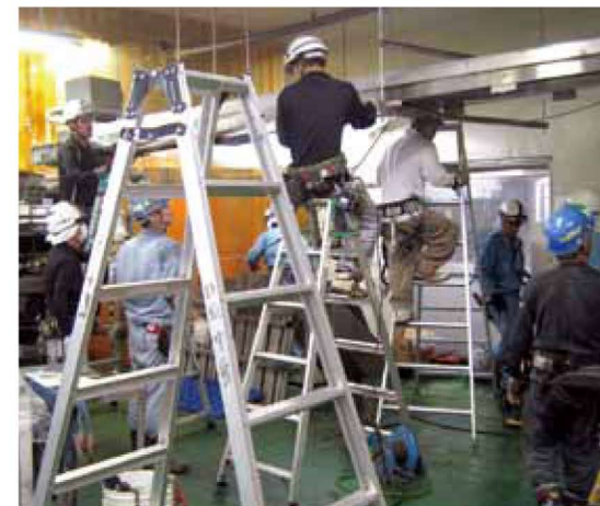
フリーザー入替に伴う包装機 レイアウト変更工事
